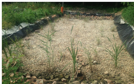
Fot. 1. Oczyszczalnia hydrofitowa
